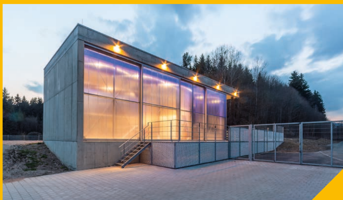
MVE PLAVY – STAVBA ROKU LIBERECKÉHO KRAJE 2025
